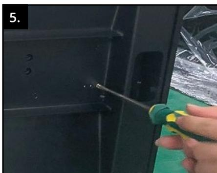
5. Befestigen Sie zusätzlich den Standfuß mit den 12 Kreuzschlitzschrauben.
