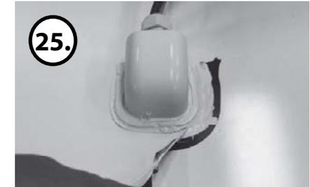
Entfernen Sie das Isolierband.
